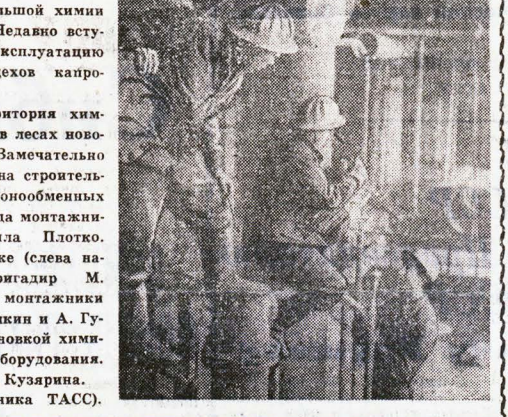
На снимке (слева направо): бригадир М. Плотко, монтажники А. Михалочкин и А. Гусев за установкой химического оборудования. Фото А. Кузьярина. (Фотохроника ТАСС).
