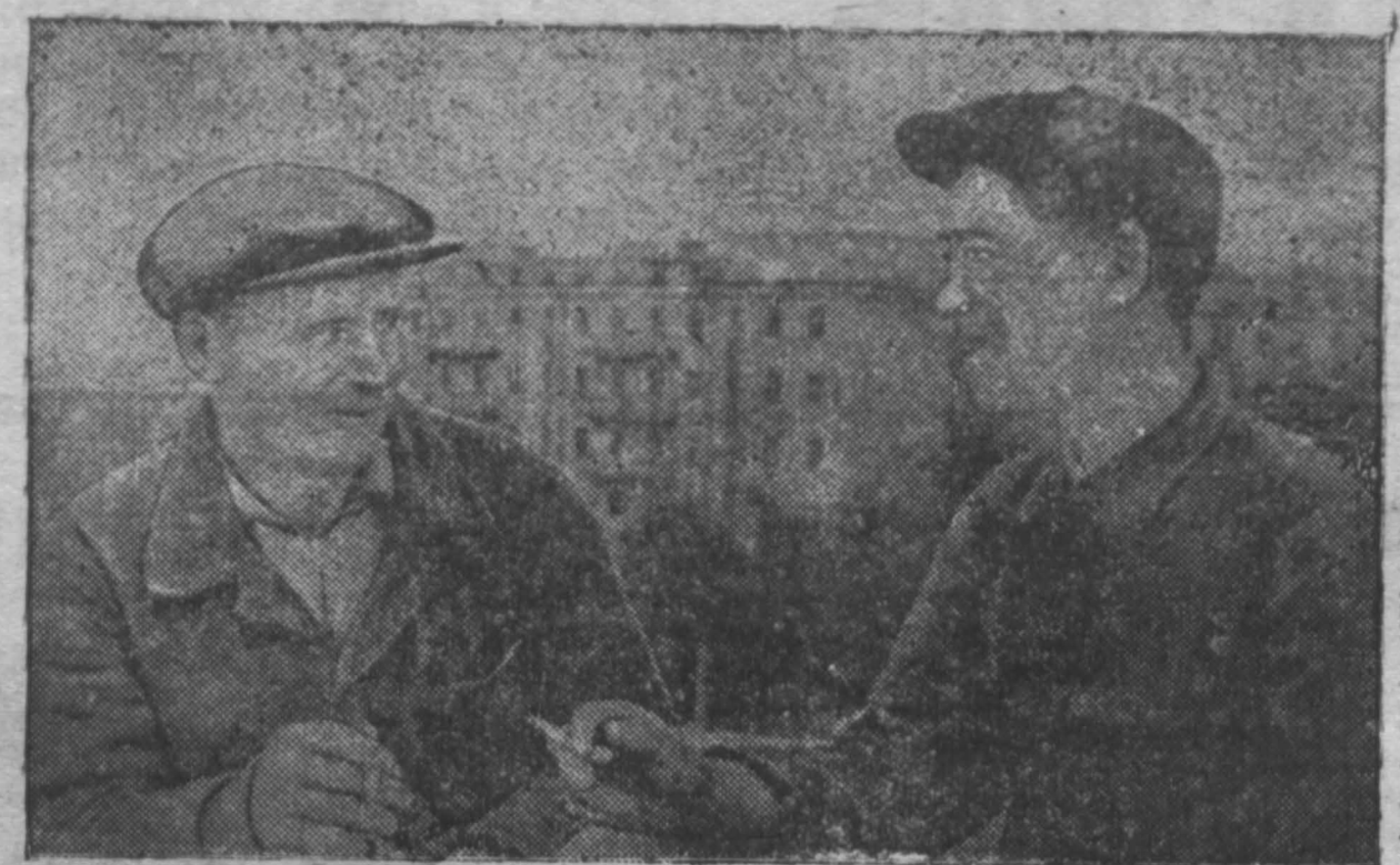
Каменщики 1-го стройуправления треста «Сталинскпромстрой» М. Т. Камнев и В. Г. Талдышев, работающие на строительстве 140-квартирного дома, ежедневно выполняют производственные задания на 150 и более процентов. На снимке: тт. Камнев и Талдышев за беседой.
